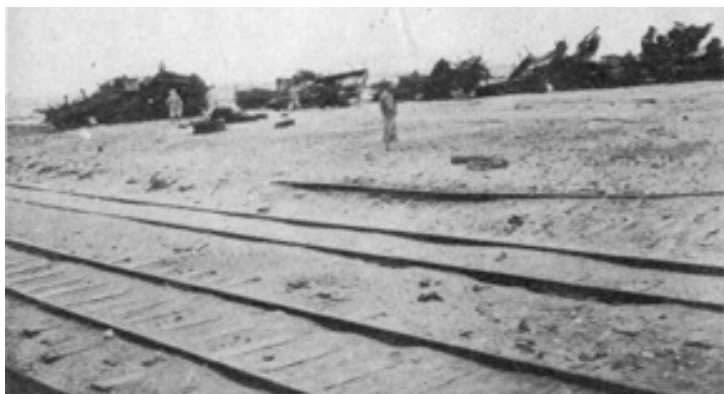
Cataste di materiale ferroviario incendiato.
