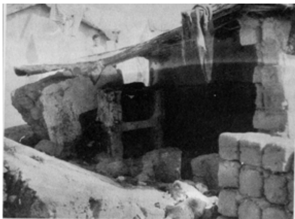
Campo di DEIR EL BALAH - Un'altra solida casetta crollata sotto il peso di... una pioggia inopportuna...
