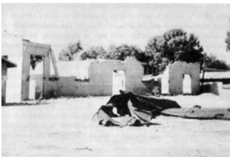
EL ARISH — L'Ospedale distrutto...
