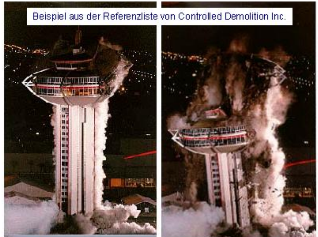
Sprengung des Landmark Hotels in Las Vegas, ca. 110m hoch, durch CD Inc. mit ca. 50 kg Sprengstoff
